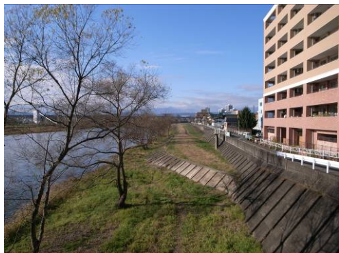
現況：明治橋上流
