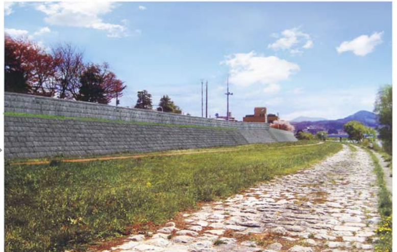
整備イメージ：自然石積護岸とする。パラペットは、自然石パネルとして石積護岸との調和を図る。
