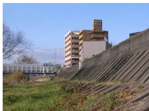
現況：明治橋下流(御蔵前付近)
